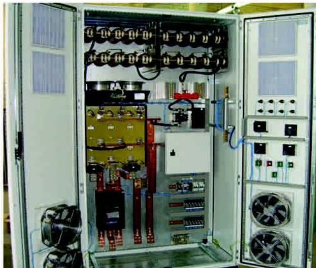
Рис.2 EX-SR-1000-115 УХЛ4 на замену ТВ (ток 1000А)
