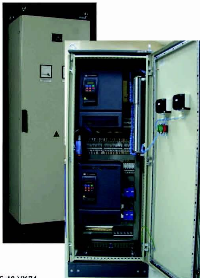
Рис.1 Каскад Пазских ГЭС. Машинный зал ГЭС-7, ШУВ-2К
