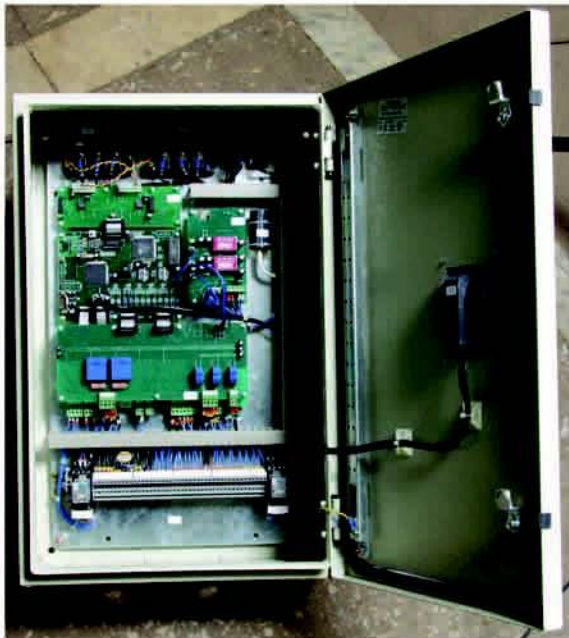
Рис.1 Система возбуждения AVR-10-BR-Q2 УХЛ4 для дизель-электростанции 1600кВт ООО "БУРГАЗ"
