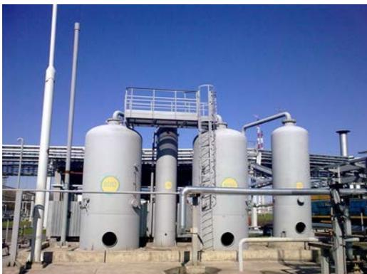
УРП состоит из двух (или более) адсорберов, работающих поочередно для обеспечения непрерывности процесса. Пока один адсорбер находится на линии в режиме адсорбции, другой отключен от линии и находится в режиме регенерации – десорбции вакуумом.
