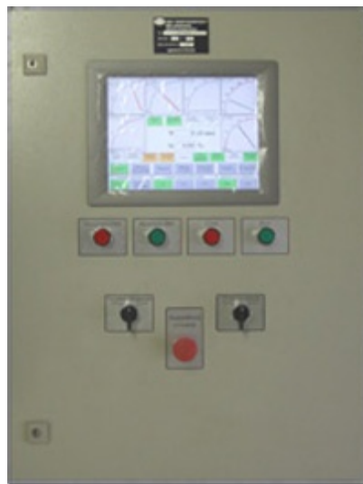
Рис. 1 Система управления СУДГ-1000-6,3 для дизеля 8ЧН32/40 (ОАО "РУМО" г. Н. Новгород) и генератора ГСД-1000-1000 (ОАО ХК "Привод", г. Лысьва)
